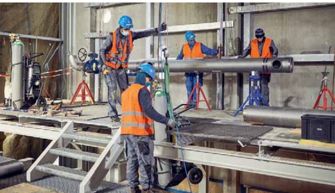
Arbeiter der Rosenmund Haustechnik AG montieren Rohre der Heizungsinstallation.
